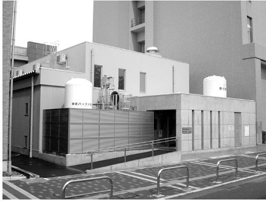
左側：ガスポンベ室 (白い塔は中圧Heガスタンク) 中央：施設本体 右側：窒素汲み出し場 (5000L窒素タンク)
