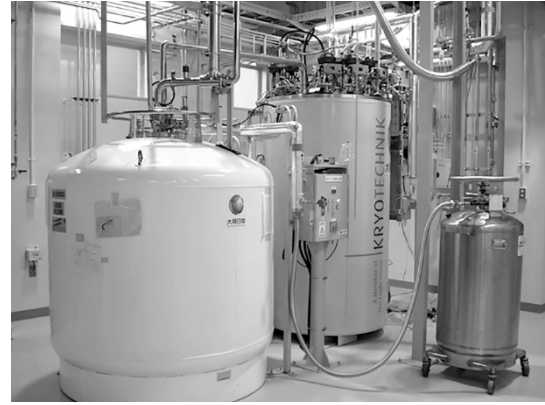
左から1500L液体ヘリウム貯槽, 液化機本体, 100L小分け容器 ガスカードルのヘリウムガスを精製し, 液化機で液化して貯槽へ液保存, 小分け容器に移して実験室で使用後蒸発ガスを回収ガスバッグへ溜める。
